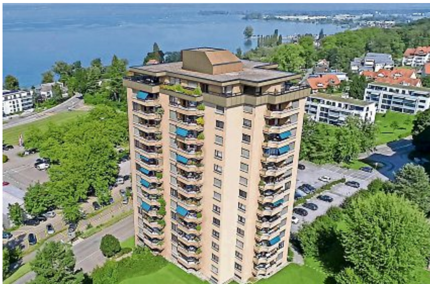
Am Tag der offenen Tür vom 18. Mai kann der «Swissair-Tower» besichtigt werden.
