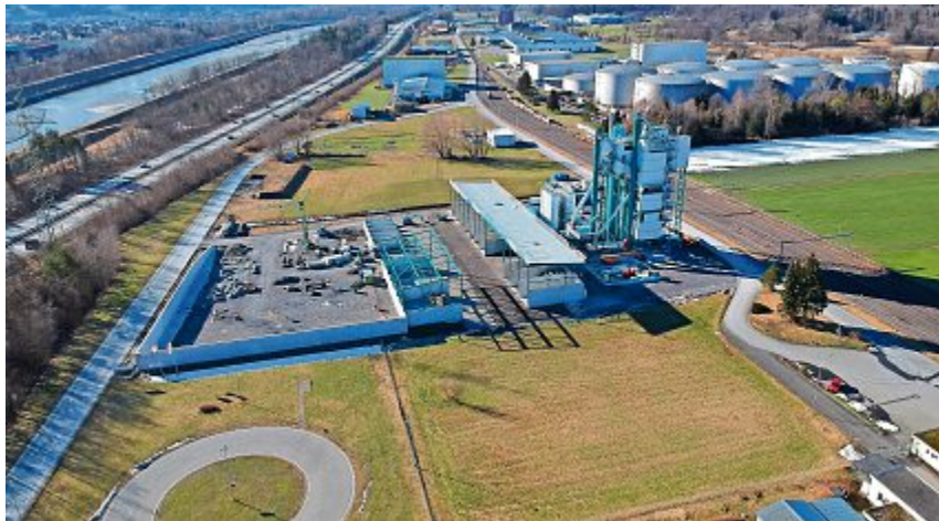
Weniger Emission, mehr Effizienz – dank neuem Mischgutwerk.
